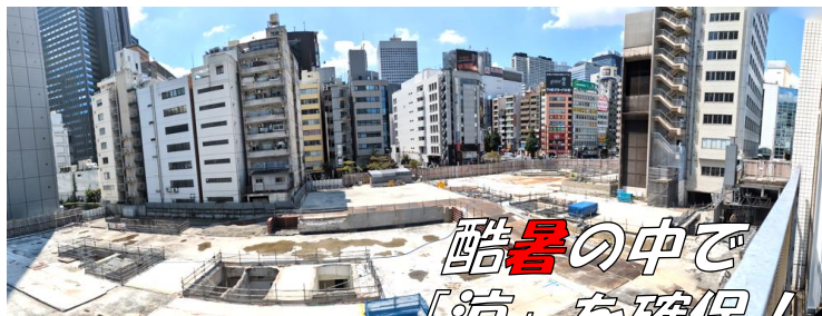
ビル取り壊し後
